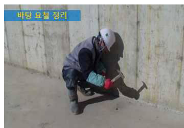
▲ 콘크리트 바탕 요철 정리
