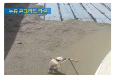
▲ 누름 콘크리트 타설
