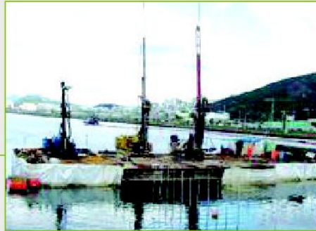
부산지하철 2호선 2단계 230공구 실드터널 보강
